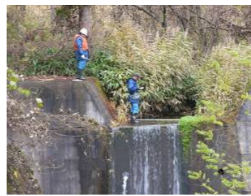
▲小水力発電電圧調査
