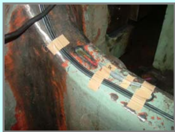
▲ひずみゲージ貼付状況
