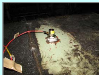
▲振動センサ設置状況
