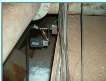
▲レーザー変位計設置状況
