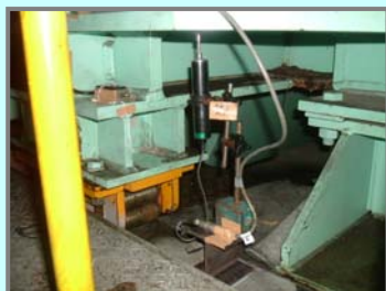
▲棒状変位計設置状況
