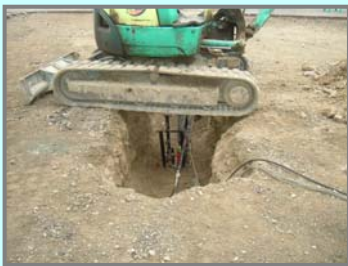
▲載荷試験状況
