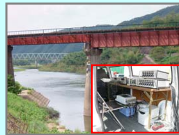
▲橋梁の応力測定状況
