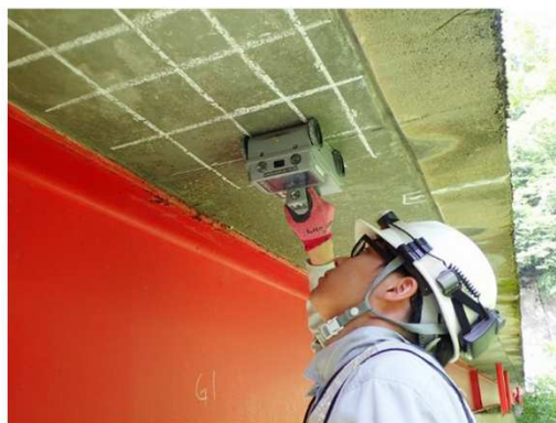
鉄筋探査状況
