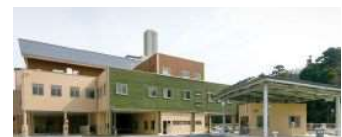
草津市グリーンセンター (整備工事監理・運転管理発注支援担当)
