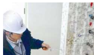
耐震工事監理
