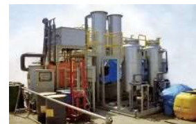
03 揚水曝気法対策工事
