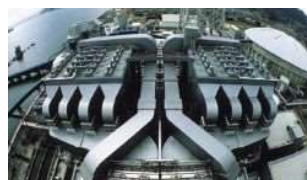
プラント試運転業務(施設イメージ)
